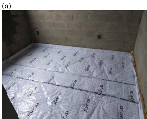
Figura 3. Manta de fibra de vidro: (a) fita na junta das placas, (b) Cuidados com cantos e rodapé.
