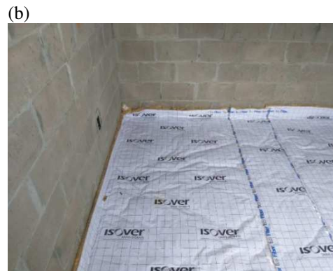
Figura 3. Manta de fibra de vidro: (a) fita na junta das placas, (b) Cuidados com cantos e rodapé.
