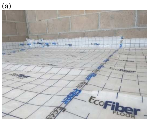
Figura 4. Manta de poliéster: (a) fita na junta das placas, (b) Cuidados com cantos e rodapé.
