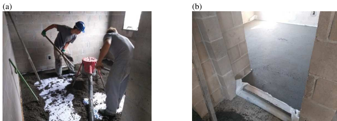
Figura 5. Execução do contrapiso: (a) Contrapiso em execução, (b) Contrapiso executado.
