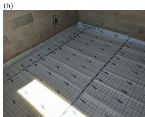
Figura 4. Manta de poliéster: (a) fita na junta das placas, (b) Cuidados com cantos e rodapé.
