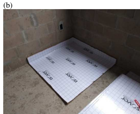
Figura 2. Placa de fibra de vidro: (a) fita na junta das placas, (b) Cuidados com cantos e rodapé.
