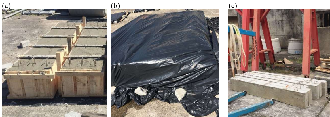
Figura 5: (a) Vigas recém concretadas; (b) Cura; (c) Vigas desformadas
