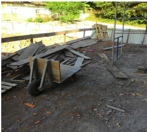
Figura 4 e 5 – Carrinho de mão e caixas de içamento vertical
