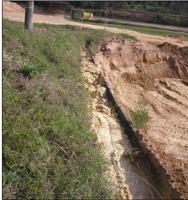
Figura 7 – Calha que conduz o efluente até as bacias de decantação.
