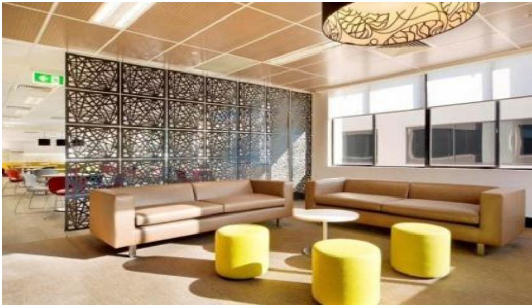
Figura 14 - Painéis metálicos vazados em chapa de aço
