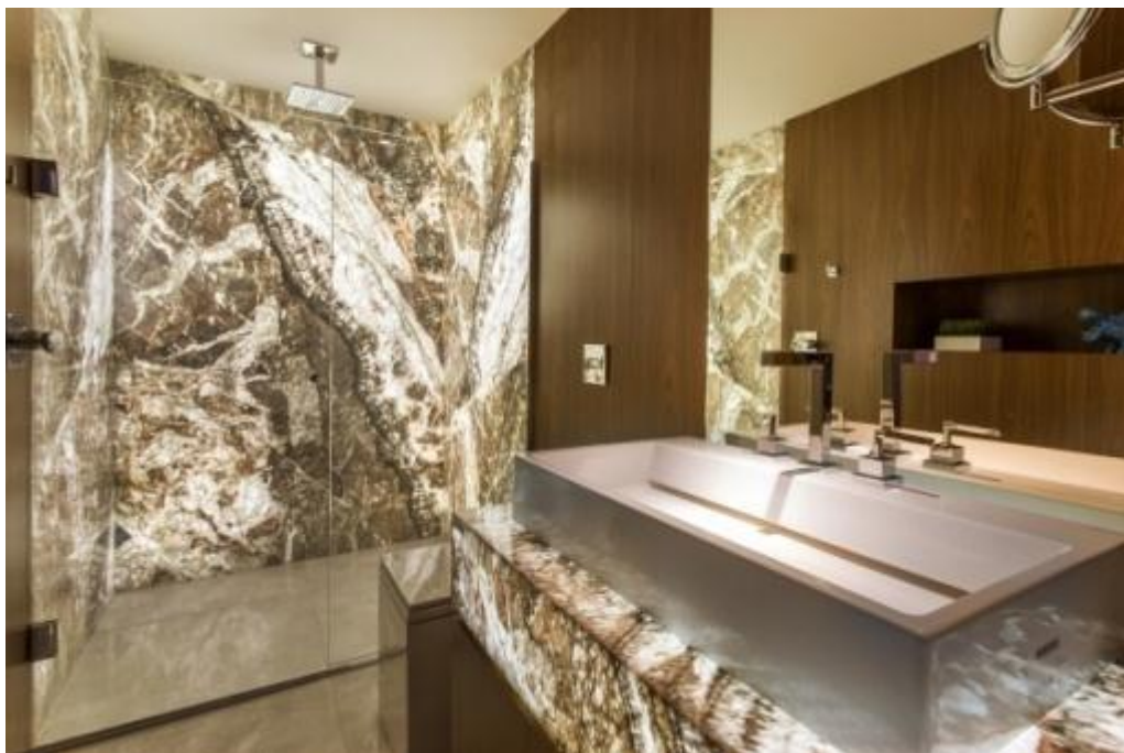
Figura 20 - Mármore translúcido em parede e bancada
