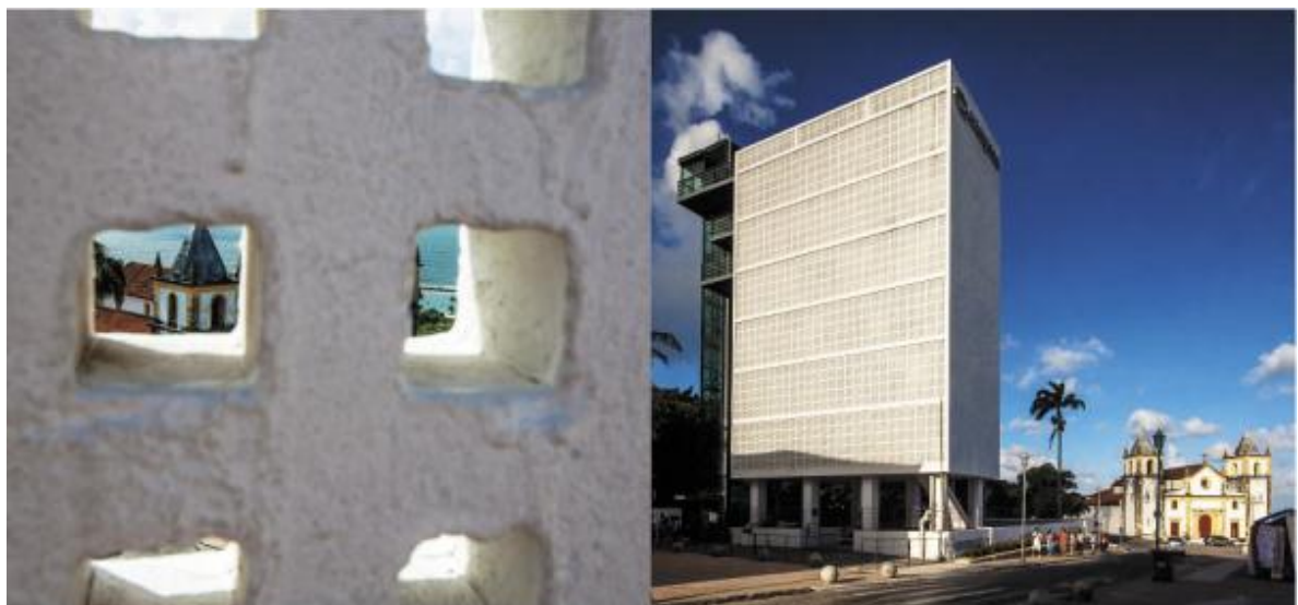
Figura 3 - Caixa D'Água de Olinda (1935) | Projeto Luiz Nunes | Foto Josivan Rodrigues
