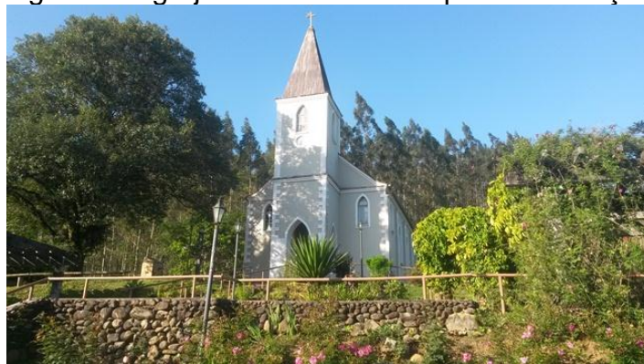
Figura 06: Igreja Santa Catarina após restauração - 2015
