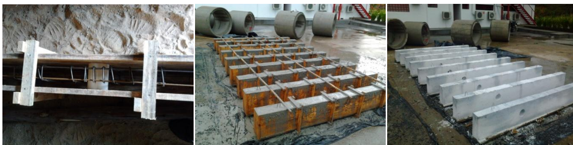
Figura 6 - Etapas de fabricação das vigas
