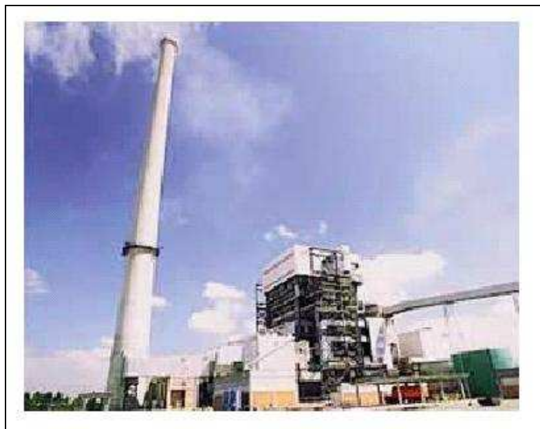
Figura 10. Unidade do complexo Termelétrico Jorge Lacerda Fonte: ANEEL (2005)
