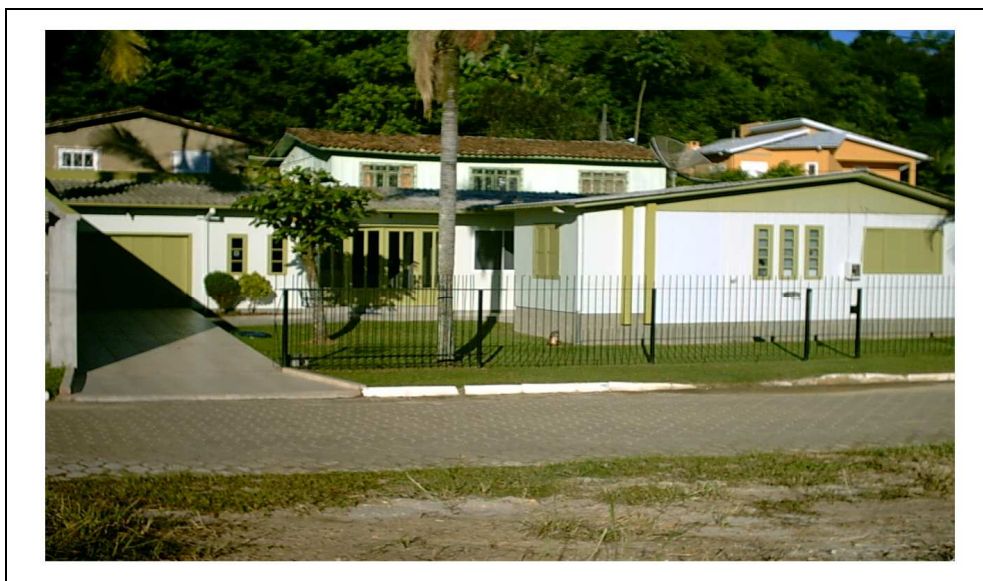
Figura 32. Residência dos testes realizados com a tecnologia PLC
