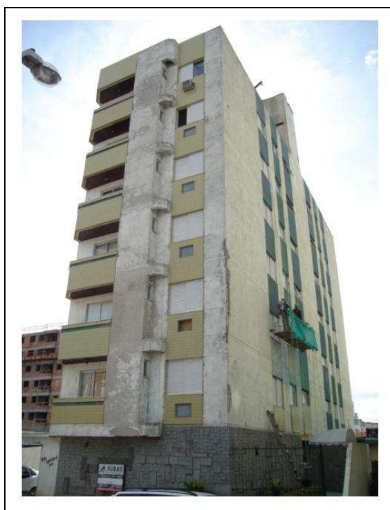
Figura 58. Foto externa do Edifício Orion
