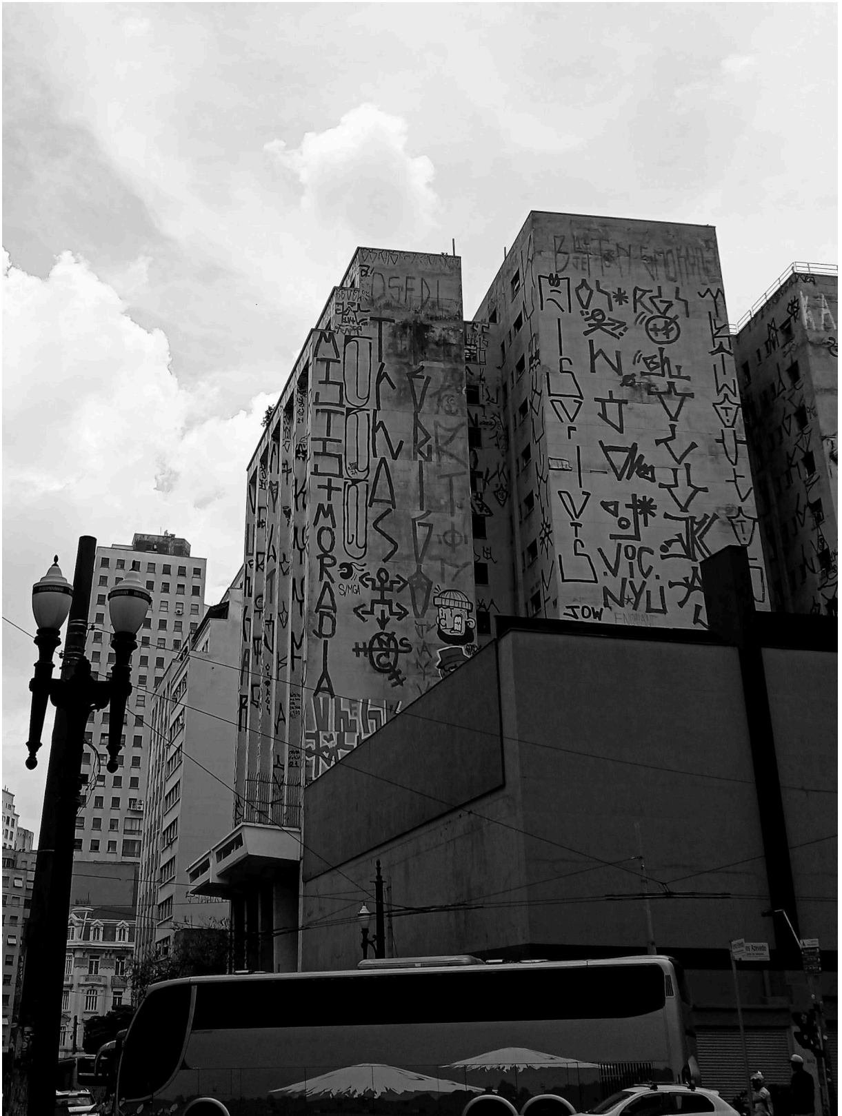
Figura 11 - Pixações em edifícios
